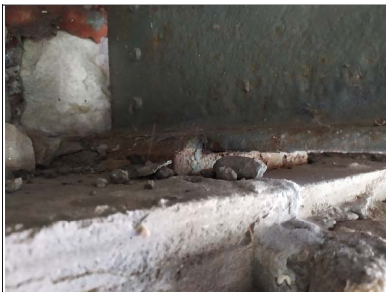
Uložení nosníku na opěře 1
