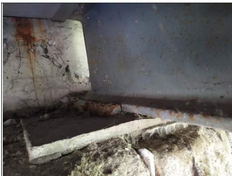
Uložení nosníku na opěře 3
