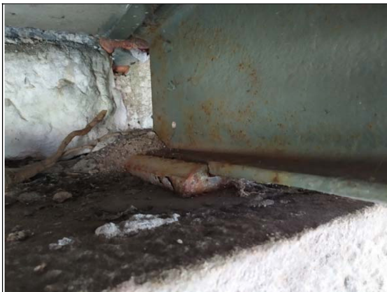
Uložení nosníku na opěře 1
