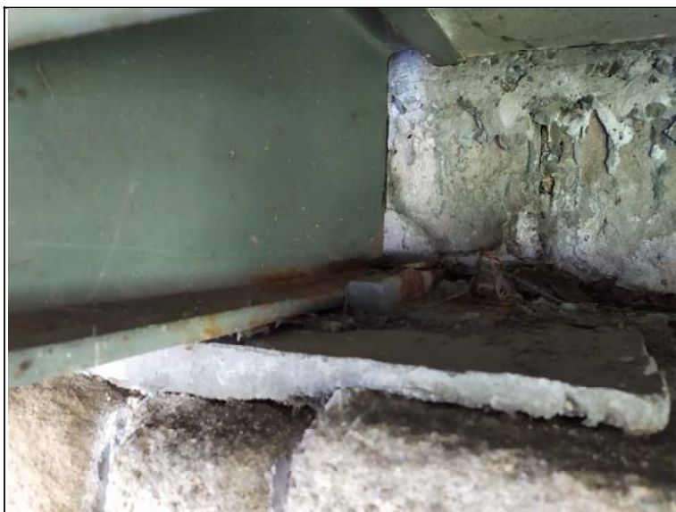
Uložení nosníku na opěře 3
