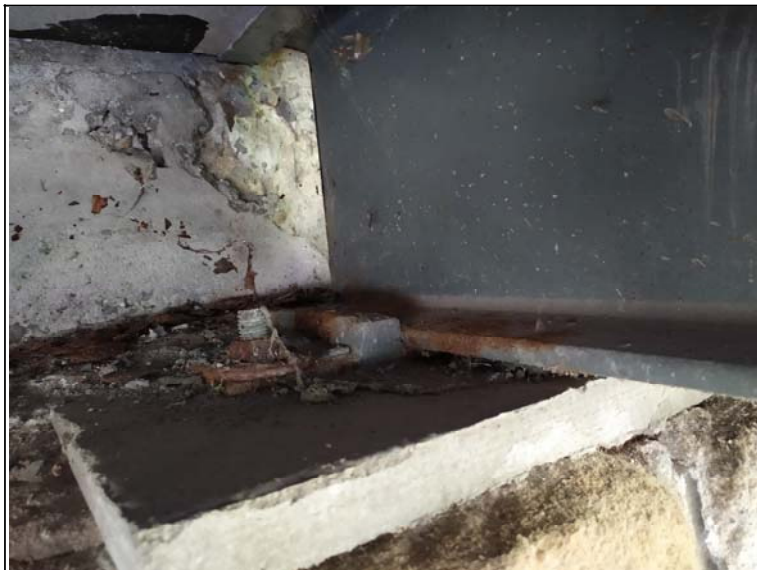
Uložení nosníku na opěře 3
