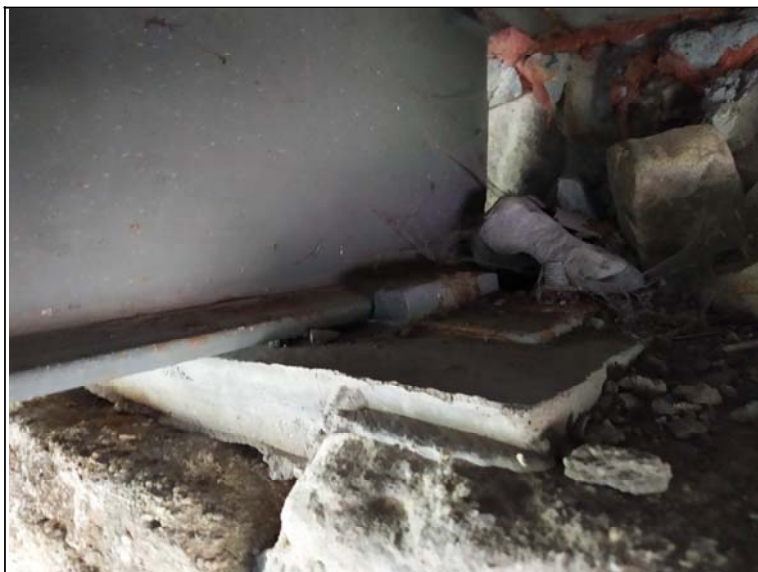
Uložení nosníku na opěře 1
