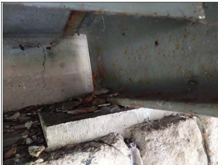
Uložení nosníku na opěře 3
