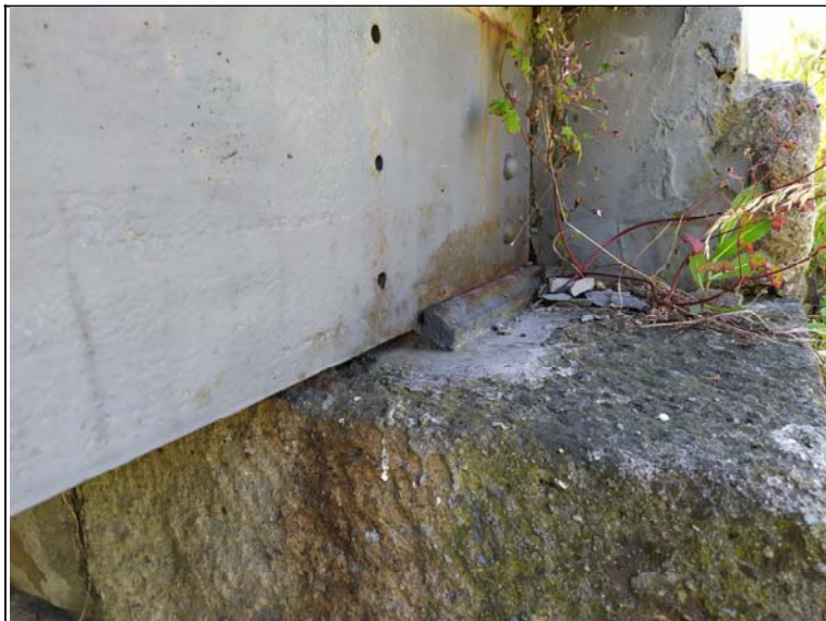
Uložení nosníku na opěře 1
