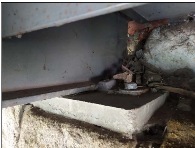
Uložení nosníku na opěře 1
