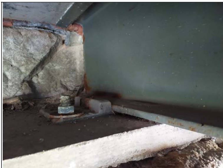
Uložení nosníku na opěře 1
