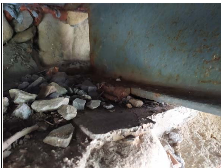
Uložení nosníku na opěře 1
