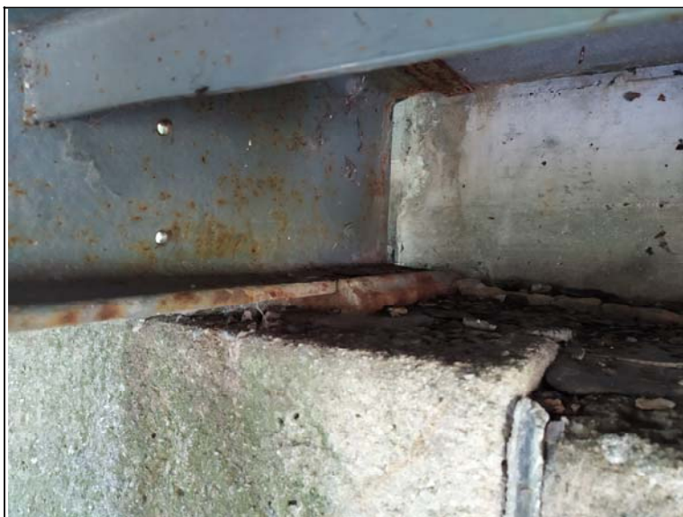
Uložení nosníku na opěře 3
