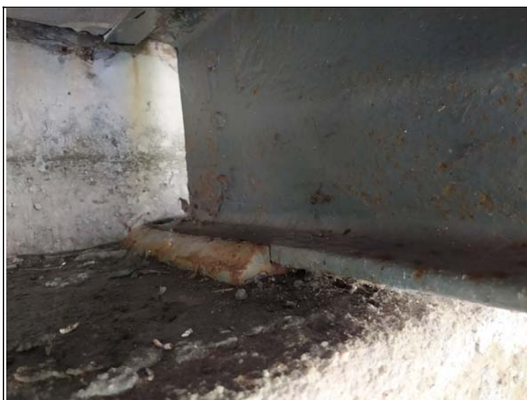
Uložení nosníku na opěře 3
