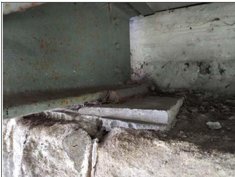
Uložení nosníku na opěře 3
