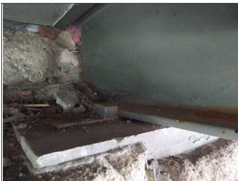
Uložení nosníku na opěře 1
