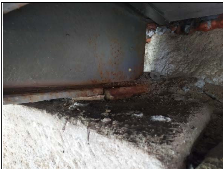
Uložení nosníku na opěře 1
